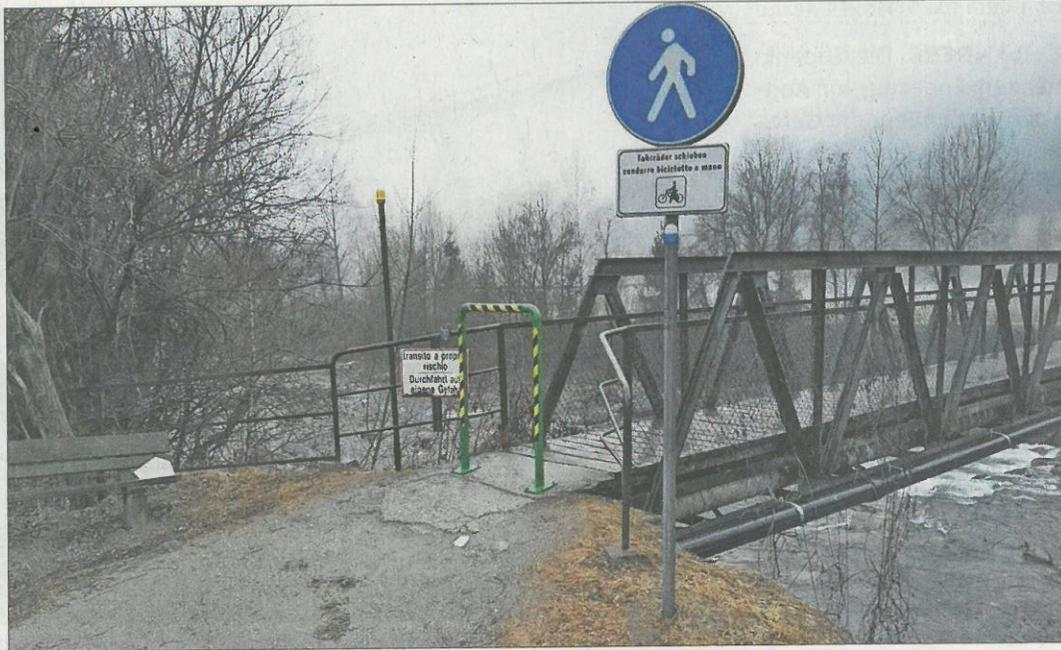
Die fast 40 Jahre alte Fachwerkbrücke bei der Kläranlage in St. Martin muss dringend neu errichtet werden, weil sie viel zu wenig Tragkraft hat. Ob die Leitungen auf die neue Brücke übertragen werden, oder ob die alte Brücke als Halterung für die Rohre bestehen bleibt, ist noch nicht entschieden. Ein Bügel verhindert, dass Pferde auf die Brücke gelangen. Radfahrer sollten die Brücke einzeln passieren.
